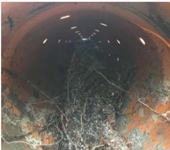
*Bilder: Wurzeln in Sickerleitung eingewachsen*
