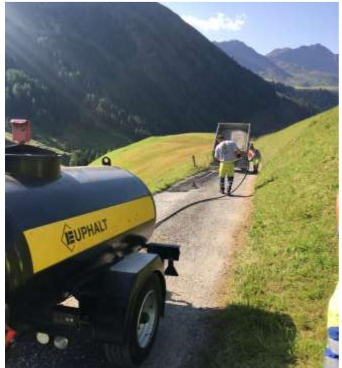
*Bild: Unterhalt an dem Spritzbelag ins Fondei.*
