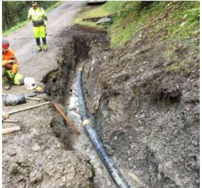
*Bild: Sickerleitung ersetzen und neu verlegen an der Verbindungsstrasse Molinis-Tschiertschen*
