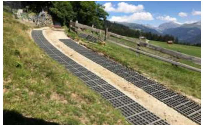
Bild: Verlegte Kunststoff-Rasengittersteine
