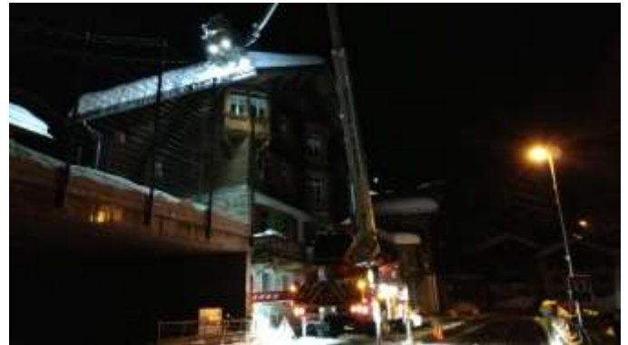
Bild: Für Gemeindeinterne Arbeitsbühnenarbeiten ist der Hubretter immer wieder im Einsatz
