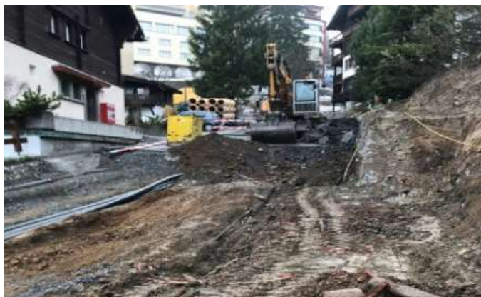
Bild: 2. Etappe Unterseestrasse inkl. Trottoir
