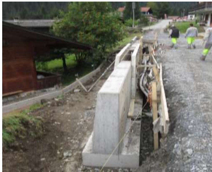
Bild: Sanierung Obere Prätschwaldstrasse Litzirüti
