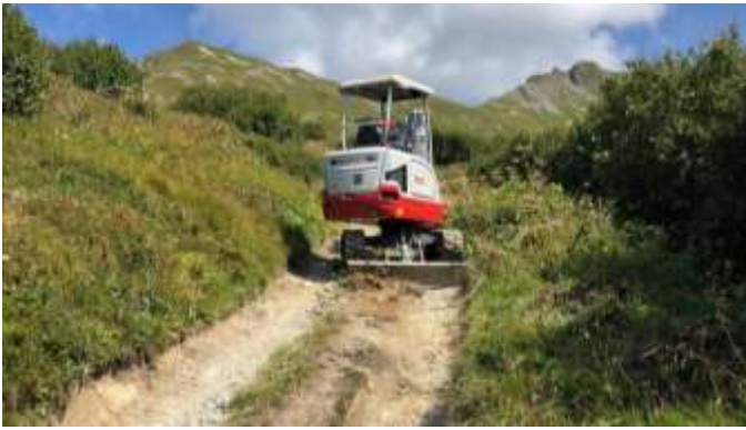
Bild: Arbeiten am Berweg mit kleinem Raupenbagger
