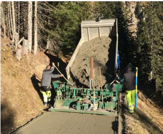
Bild: Einbau der Verschleisssschicht mit LKW
