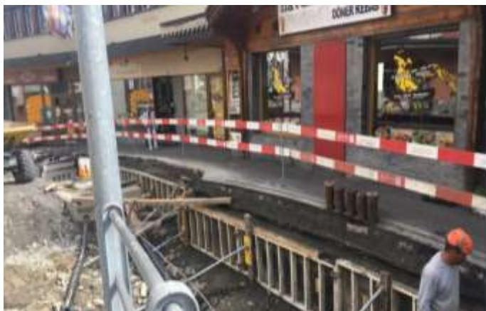
Bild: 2. Etappe Poststrasse inkl. Trottoir
