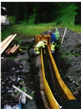
Bild: Fundament und neue Gasleitung
