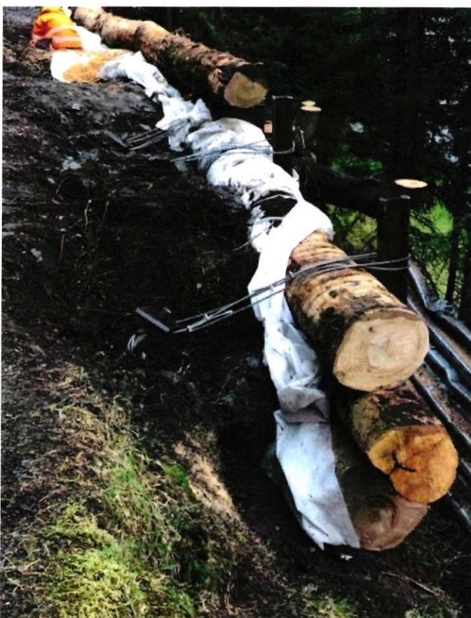
Bild: neue Rundholzkonstruktion Obere Waldpromenade
