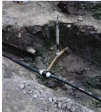
Bilder: Ersatz-Wasserleitung Pudanal
