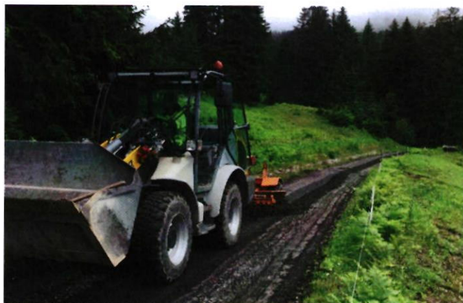
Bild: Strassenunterhalt mit Gräder
