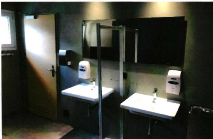
Bild: sanierte Sanitäranlage der Damen
