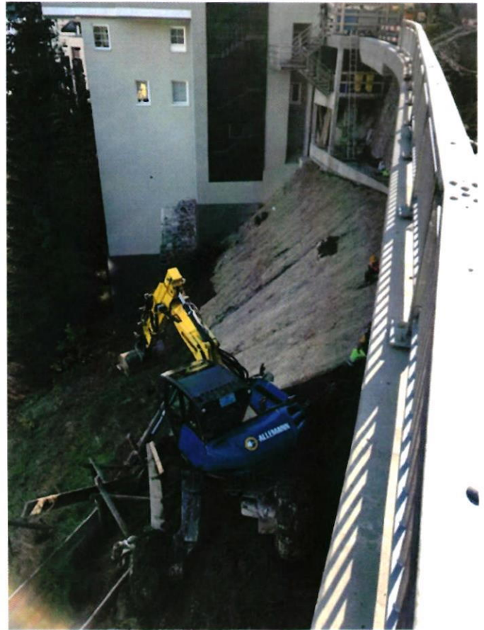
Bilder: Humusierarbeiten Halde Seegrube
