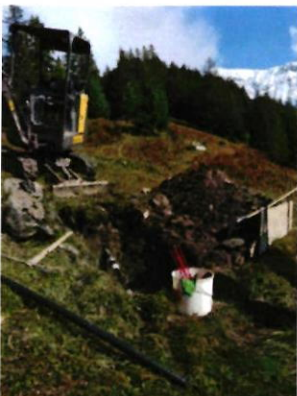
Bilder: Wasserrohrbruch Versorgungsleitung Calfreisen
