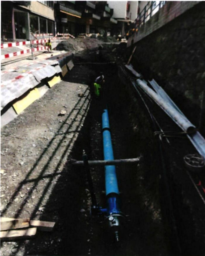
Bild: Neue Wasserleitung Lehenbrücke
