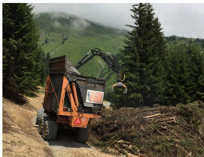
Bild: Rodungsarbeiten Meliorationsweg Lüen, Bargun
