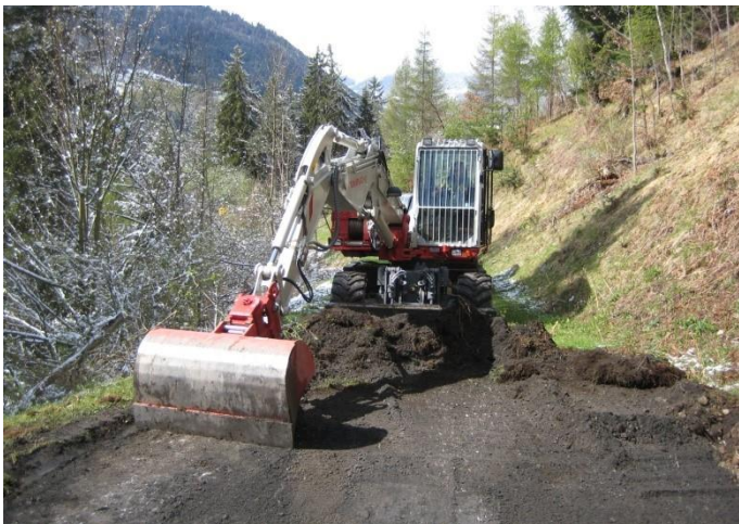
Bild: Instandstellungsarbeiten am Feldweg in Calfreisen. Einsatz des gemeindeeigenen Mobilbaggers
