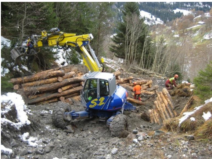
Bild: Holzkastenbau im „Rufanatöbeli“ in Peist. Anspruchsvolle Arbeiten im steilen Gelände, welches eine sehr gute Zusammenarbeit zwischen Forstgruppe und Unternehmung erfordert
