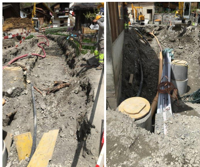
Bild: Sanierung Bahnhofstrasse Molinis samt Werksleitungen
