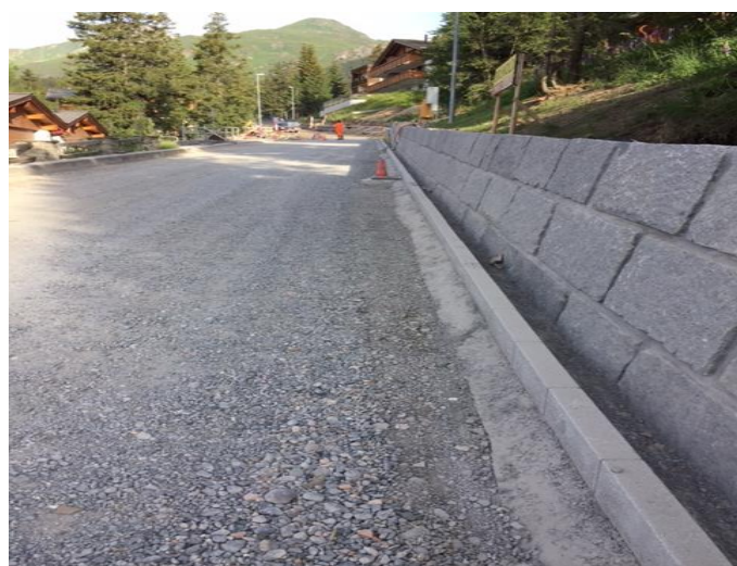
Bild: Fertigstellung Maranerstrasse 2. Etappe sowie Errichtung Stützmauern
