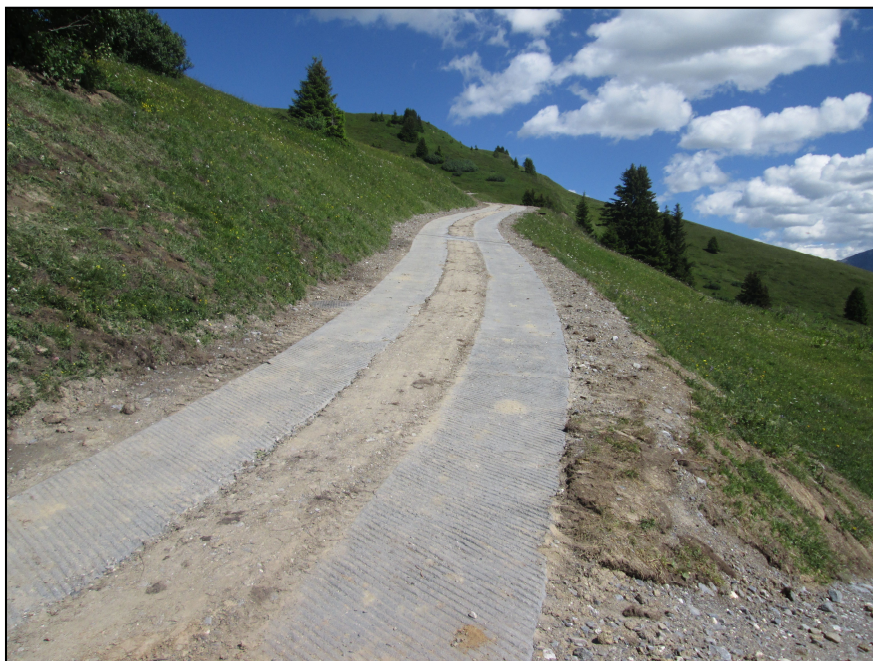
Beispiel: Betonspurweg Zalüenja im Bauzustand, St. Peter (2016)
