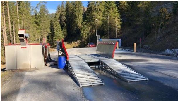
Abbildung 7: LKW- Gewichtswaage mit digitaler Übermittlung
