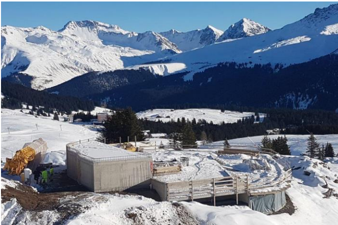
Bild: Bärenland Rohbauende vor dem Einwintern
