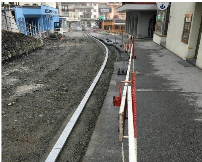
Bild: 1. Etappe Sanierung Poststrasse inkl. Trottoir
