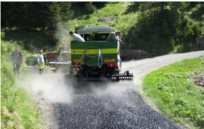
Bild: Einbau der Schottertränke am Fondeierweg
