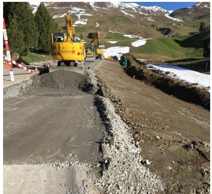
Bild: Sanierung Eggastrasse
