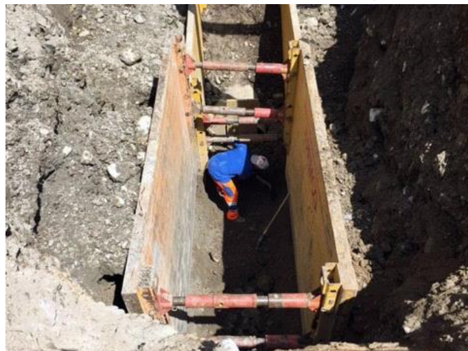
Bild: Sanierung GEP Strang E
