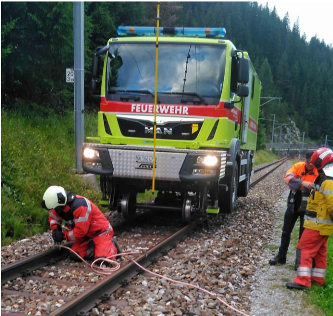
Bild: Maschinist beim Erden der Fahrleitung, zwischen Litzirüti und Langwieserviadukt
