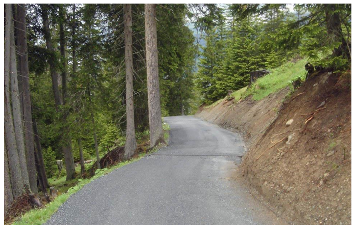
Foto: Weg mit eingebautem Planiematerial und neuen Querabschlägen.
