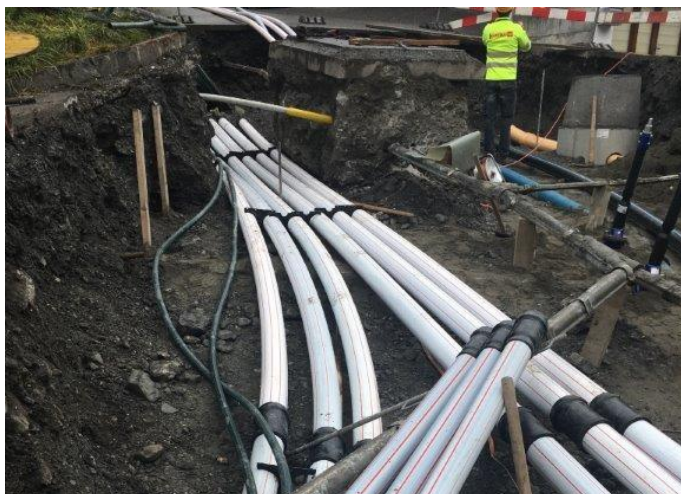
Bild: Sanierung Dorfstrasse Molinis
