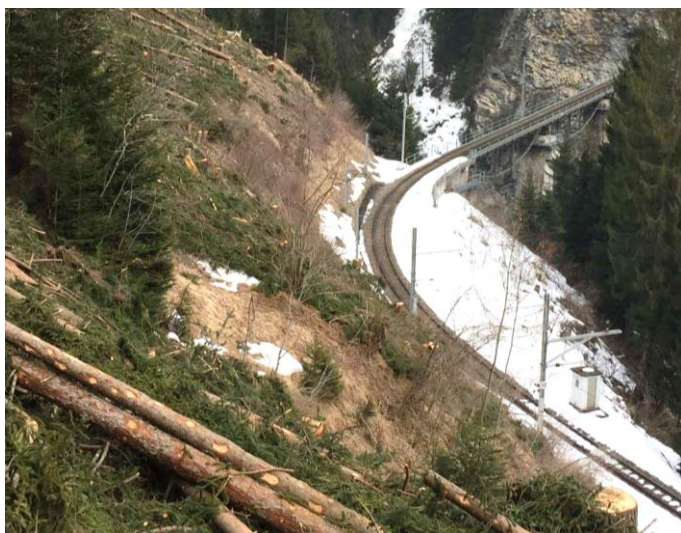
Bild: Sicherheitsholzerei RhB Castiellerviadukt
