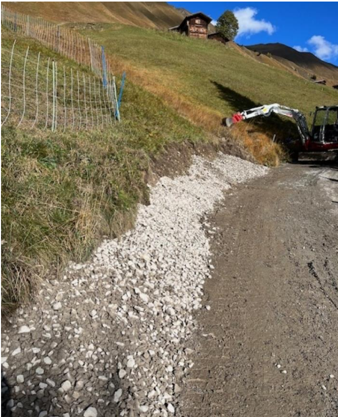
Bild: neue Entwässerung Sapünerstrasse
