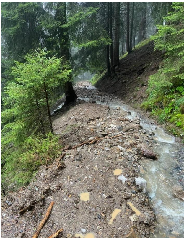
Bild: Unwetterschäden an Waldstrasse
