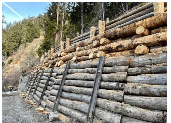
Bild: Holzkasten mit Steinschlagpalisade (Werk- und Forstgruppe)
