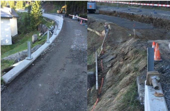
*Bild: Der neu erstellte Kordon verhindert das Abrutschen der Strasse in Richtung der Liegenschaft Rehwiesä*
