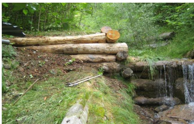
Bild: Für die Reparaturarbeiten der Bachsperrren wurde Kastanienholz eingesetzt.
