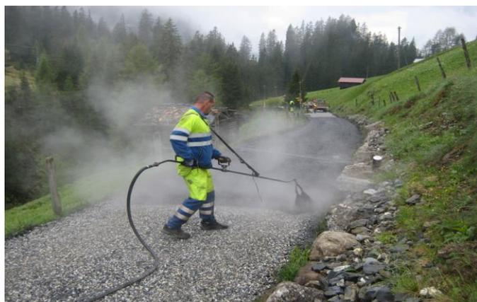
Bild: Aufspritzen einer Bitumenemulsion auf den vorgelegten 11/16 Splitt
