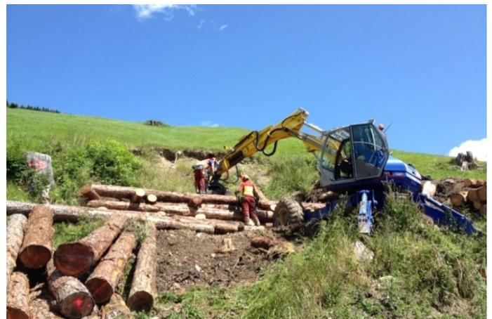
*Bild: Sicherung der bergseitigen Böschung mittels Holzkasten im Gebiet „Sulsch“ Pagig.*
