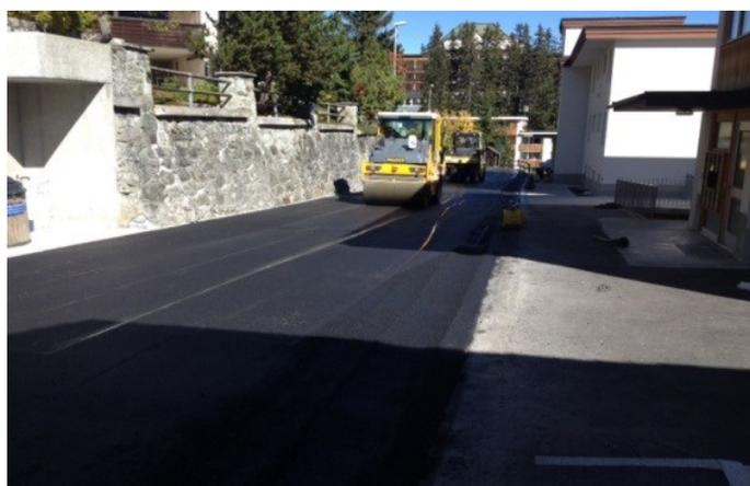
*Bild: Einbau Deckbelag Hohe Promenade*
