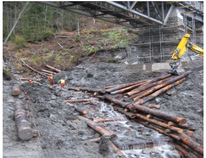
*Bild: Interessante Arbeiten für die RhB; Erstellen eines Bachverbaus im „Grosstobel“ durch die Forstgruppe Langwies.*
