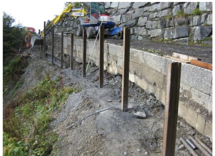
Bild: Sicherung talseitige Böschung durch „Ribbertverbau“ im Rahmen des SIE-Projektes 2014 in Calfreisen.
