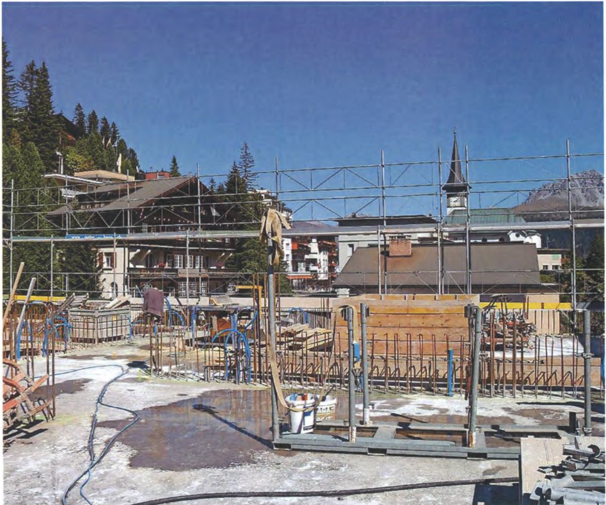
Auf dem Dachgeschoss des neuen Schulhauses.
