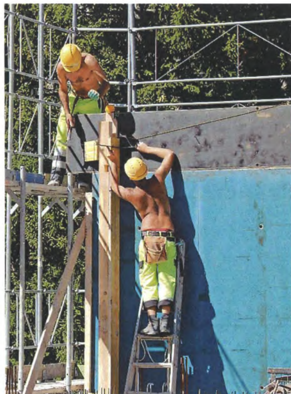
Bei der Arbeit am letzten Geschoss; die gelbe Schnur zeigt bereits das Dach an.
