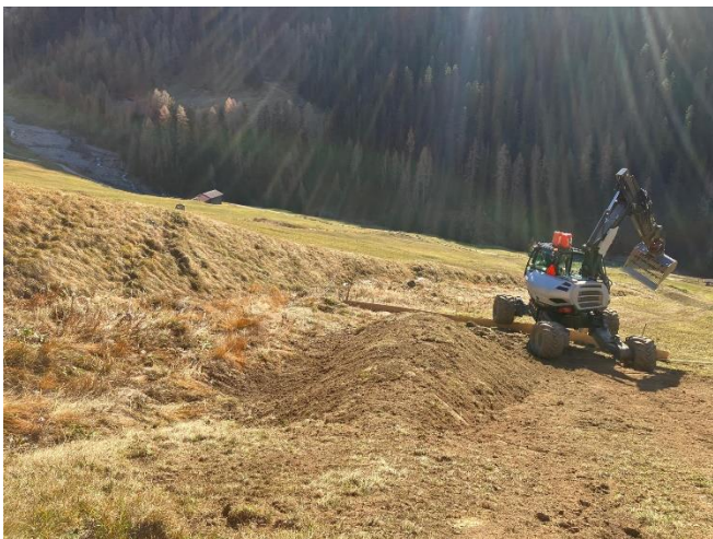
Bild: Abschlussarbeiten SIS Sapün-Schmitta
