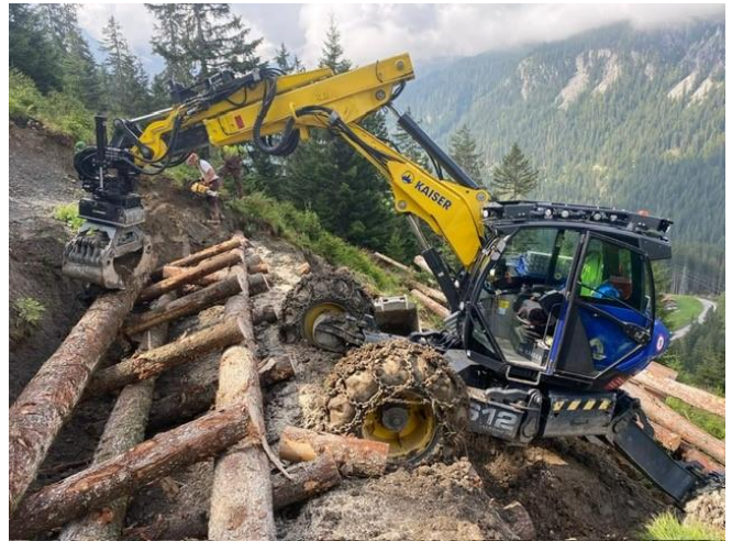
Bild Holzkasten Hangsicherung Gmeindswald Langwies
