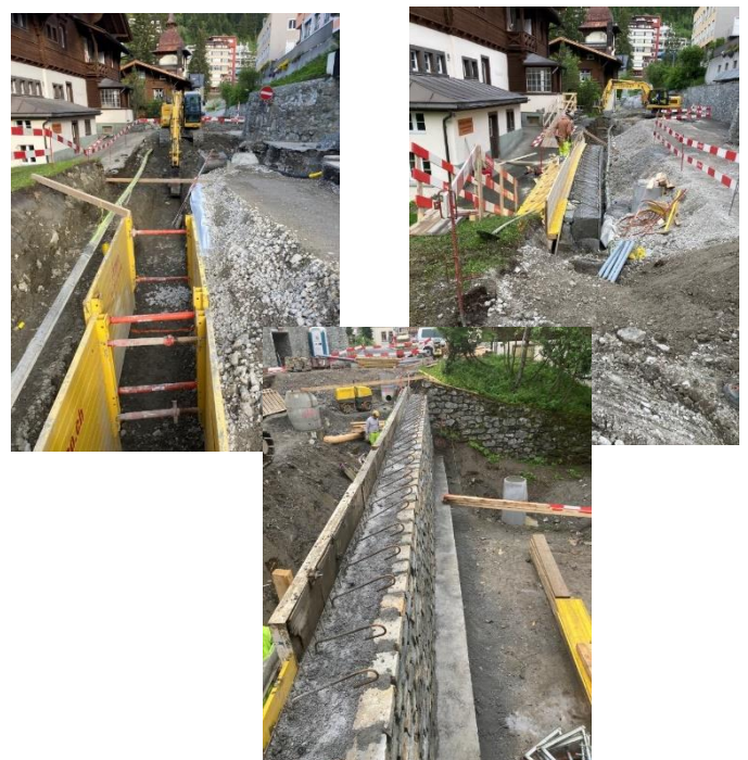
Bilder: Sanierung Alteinstrasse, Kanaldielen, Natursteinstützmauer
