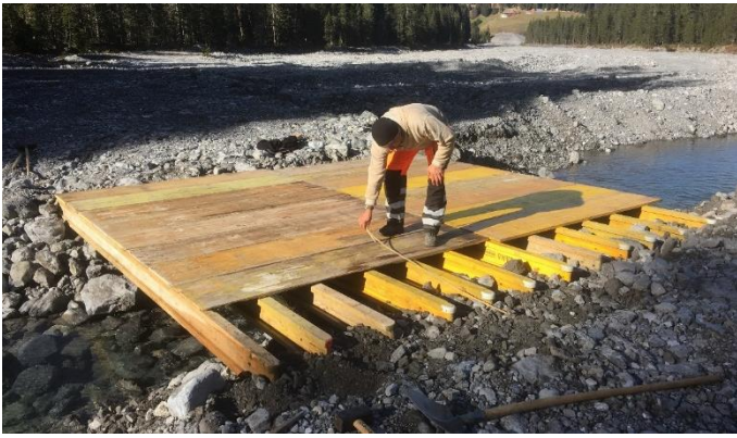
Bild: Beispielbild Bau einer Brücke für den Loipen-Betrieb
