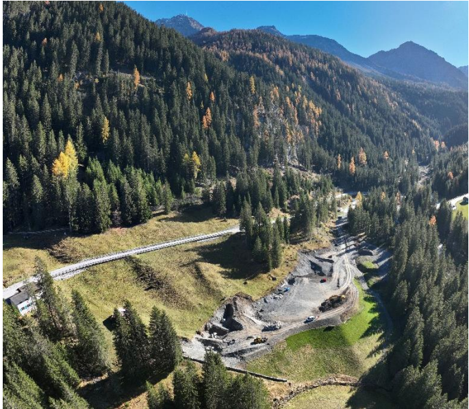
Bild: Aktueller Stand der Aufschüttung der Deponie Ris in Langwies (Herbst 2024)
