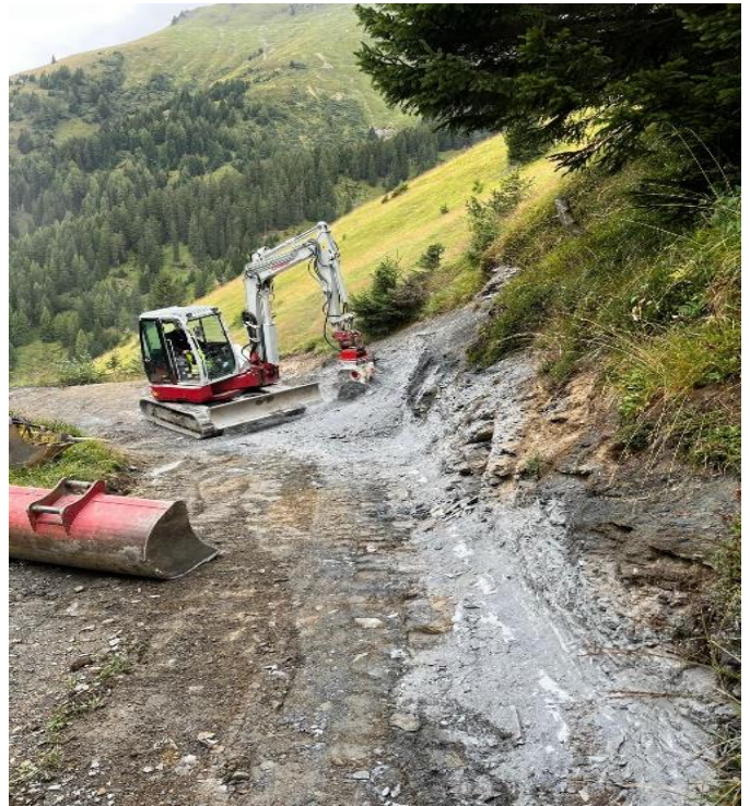
Bild: Bagger mit Felsfräse am Calfreiser-Bergweg
