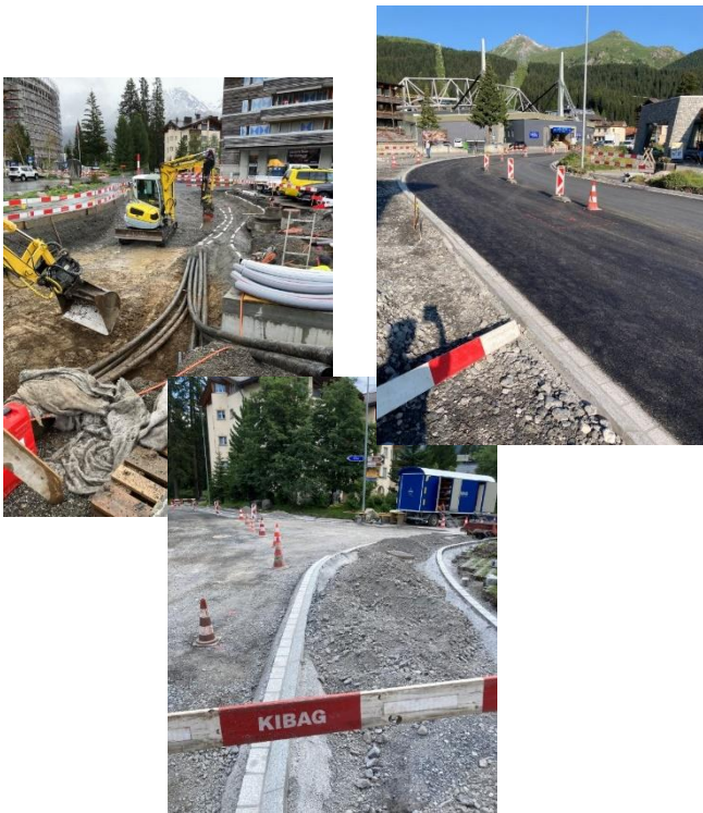
Bilder: Poststrasse, Berandungen, Werkleitungen
