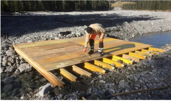
Bild: Beispielbild Bau einer Brücke für den Loipen-Betrieb
