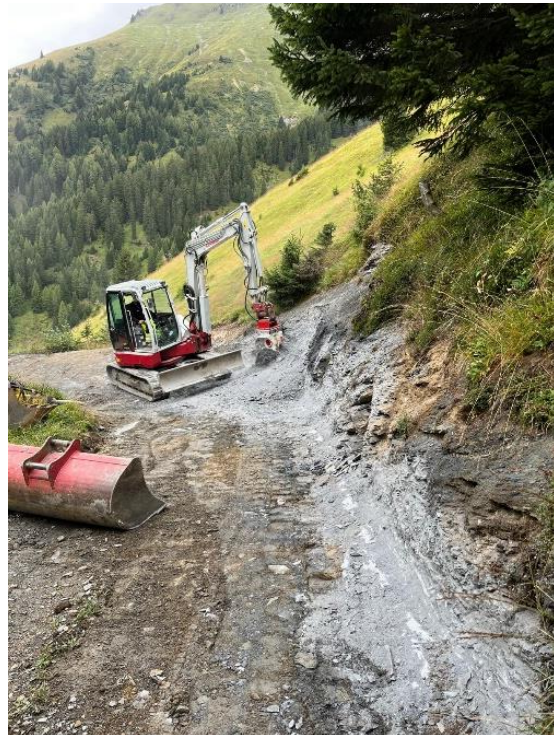
Bild: Bagger mit Felsfräse am Calfreiser-Bergweg
