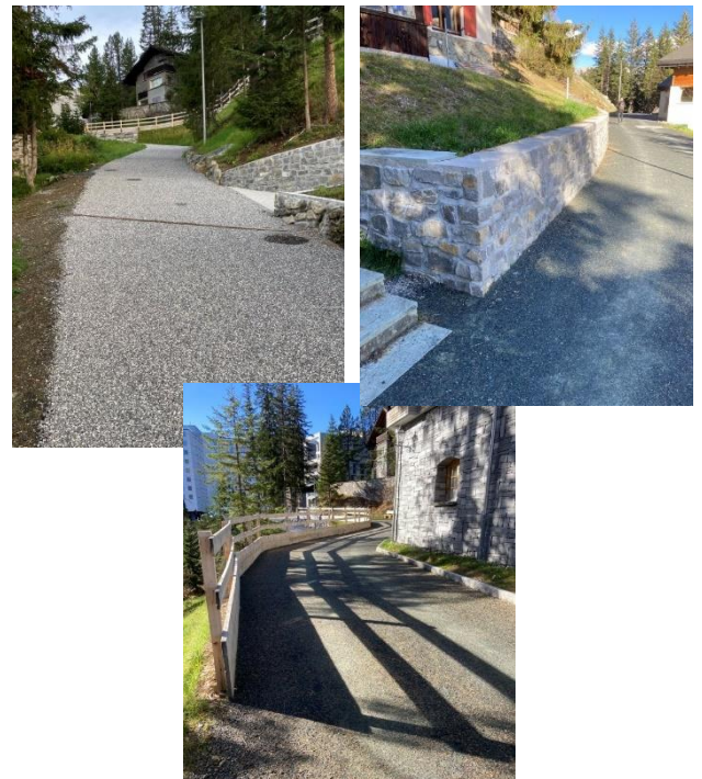
Bilder: Wegsanierung obere Waldpromenade
