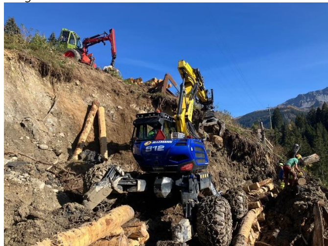
Bild: Hangsicherung Mast 32 Arosa Energie Peist
