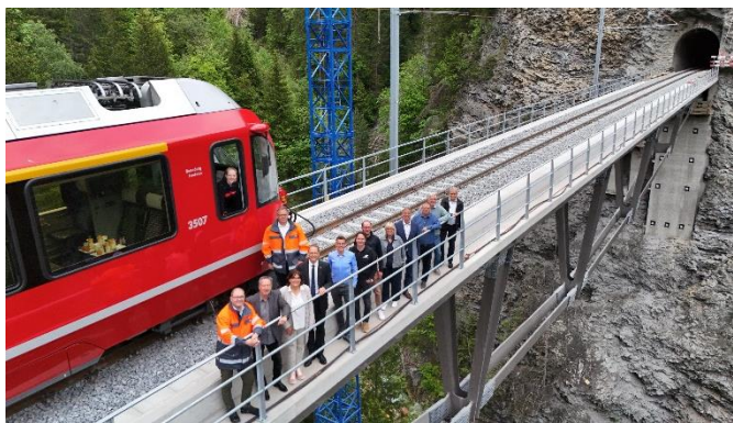
Bild: neues Castiellerviadukt (Quelle: Rhätische Bahn)
