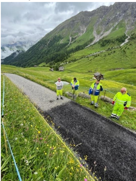
Bild: Einbau der Schottertränke mit der Firma Euphalt
