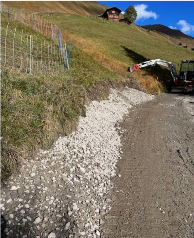
Bild: neue Entwässerung Sapünerstrasse
