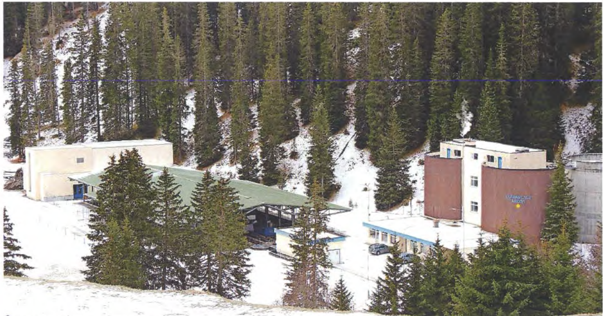
Bei der ARA in Arosa werden 2019 die Vorklärbecken saniert. Kostenpunkt: 590 000 Franken.
