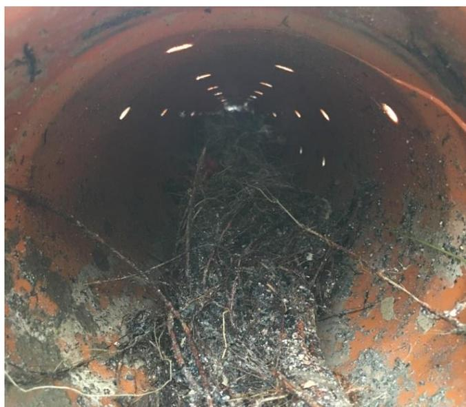
*Bilder: Wurzeln in Sickerleitung eingewachsen*
