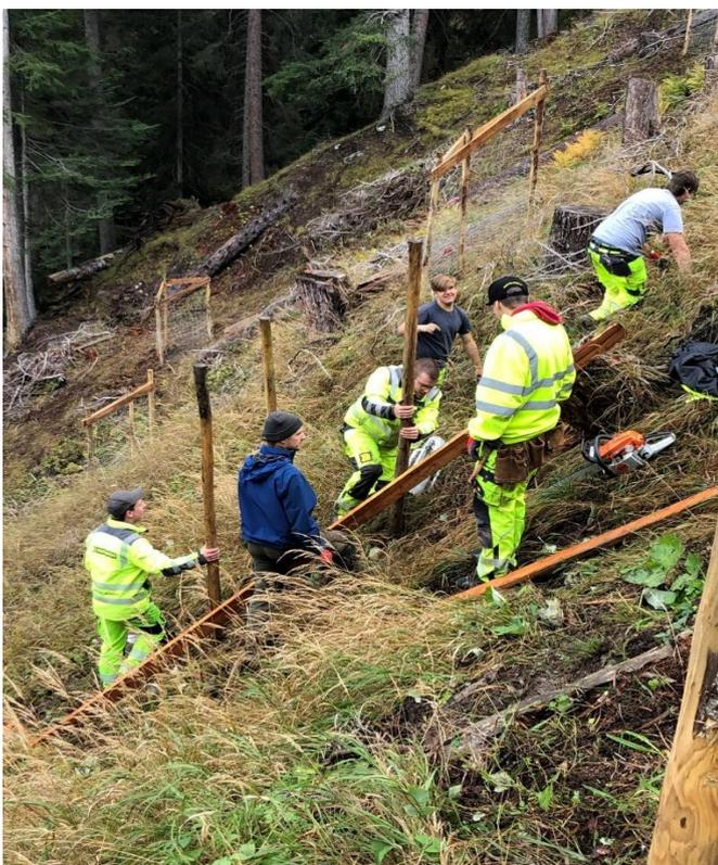
Bild: Lernende der Firma Birchmeier beim Bau von Einzelschützen.
