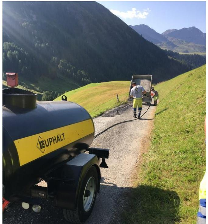
Bild: Unterhalt an dem Spritzbelag ins Fondei.
