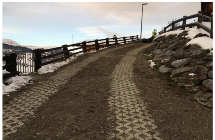
Bild: Eingebaute Rasengittersteine am alten Bergweg in Pagig
