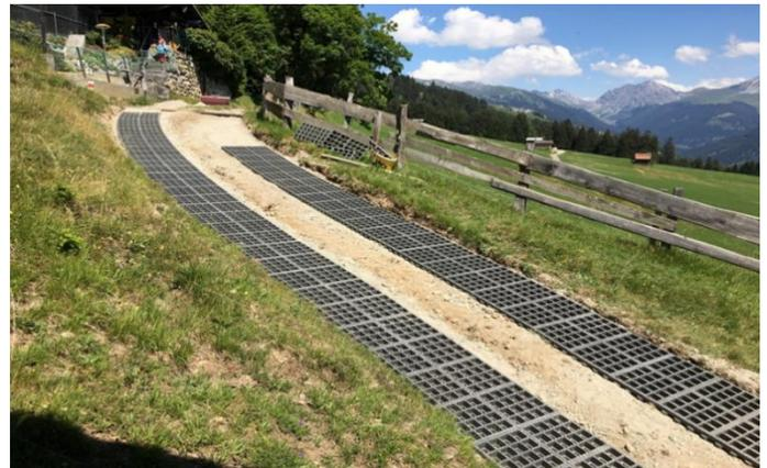
*Bild: Verlegte Kunststoff-Rasengittersteine*
