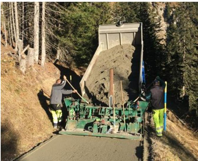
Bild: Einbau der Verschleisssschicht mit LKW
