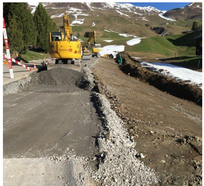
Bild: Sanierung Eggastrasse
