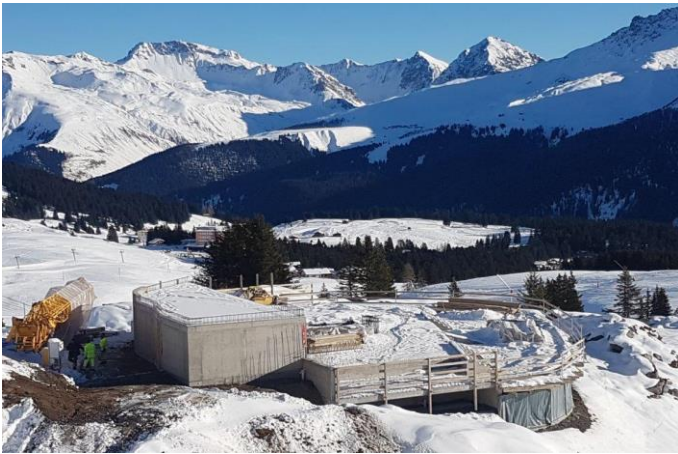
Bild: Bärenland Rohbauende vor dem Einwintern
