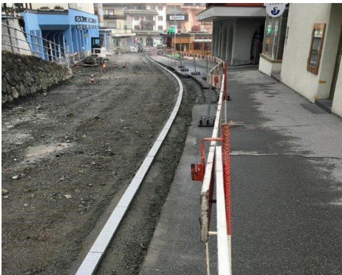
Bild: 1. Etappe Sanierung Poststrasse inkl. Trottoir
