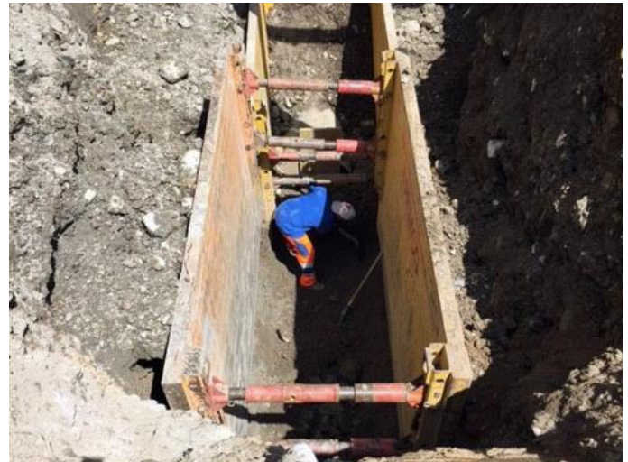
Bild: Sanierung GEP Strang E
