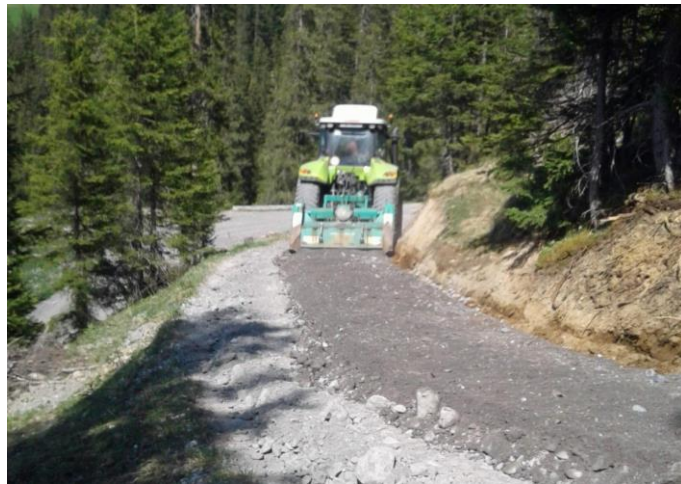
Bild: Traktor beim Brechen vom Material aus dem Furkabach
