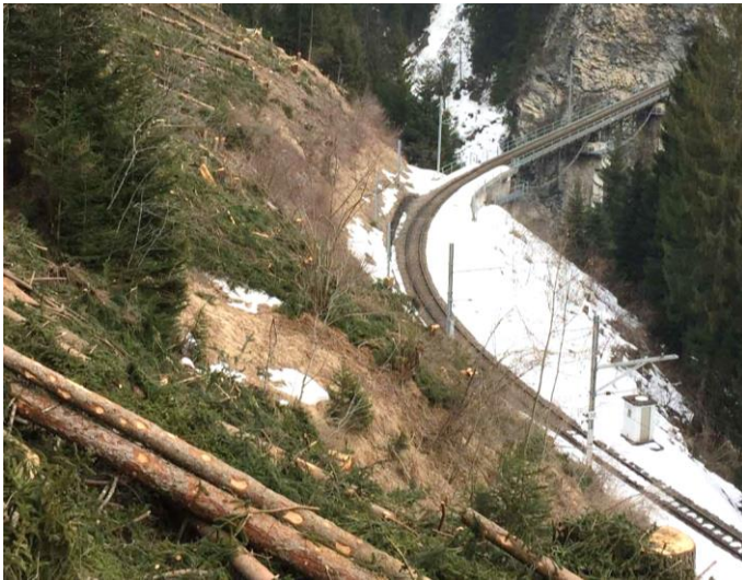
Bild: Sicherheitsholzerei RhB Castierviadukt
