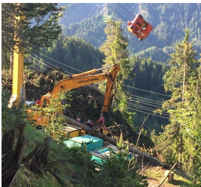
Bild: Ganzbaumverfahren im Holzschlag Valschamälas Pagig
