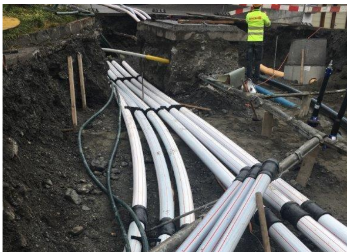
Bild: Sanierung Dorfstrasse Molinis
