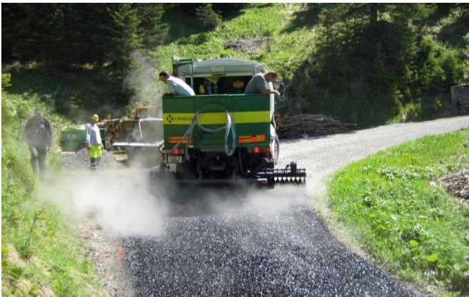
Bild: Einbau der Schottertränke am Fondeierweg
