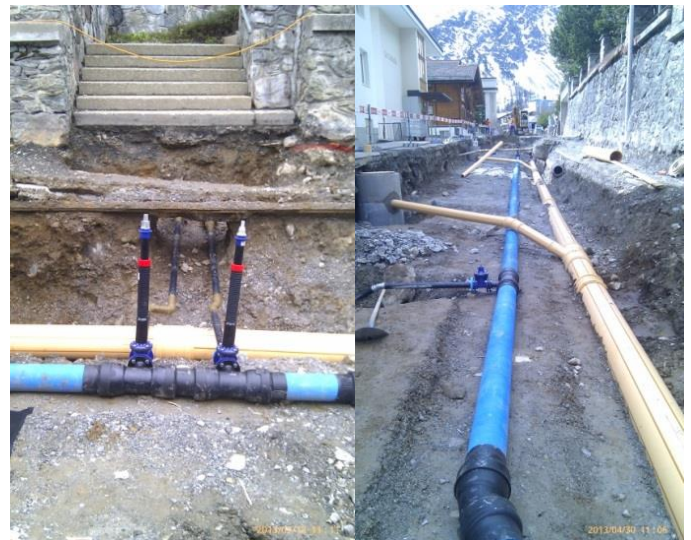
Bilder: neue Wasserleitung Hohe Promenade
