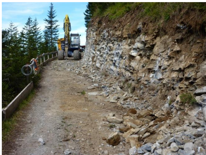
SIE 2013 Instandstellung Setaweg Langwies
