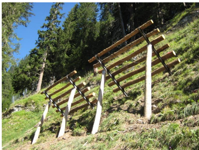
Bild: Neubau Lawinverbauungen Typ Rempar Grischun 2013 Len, Langwies
